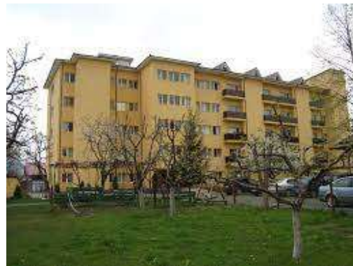
Centrul de recuperare și reabilitare persoane cu handicap Comănești
